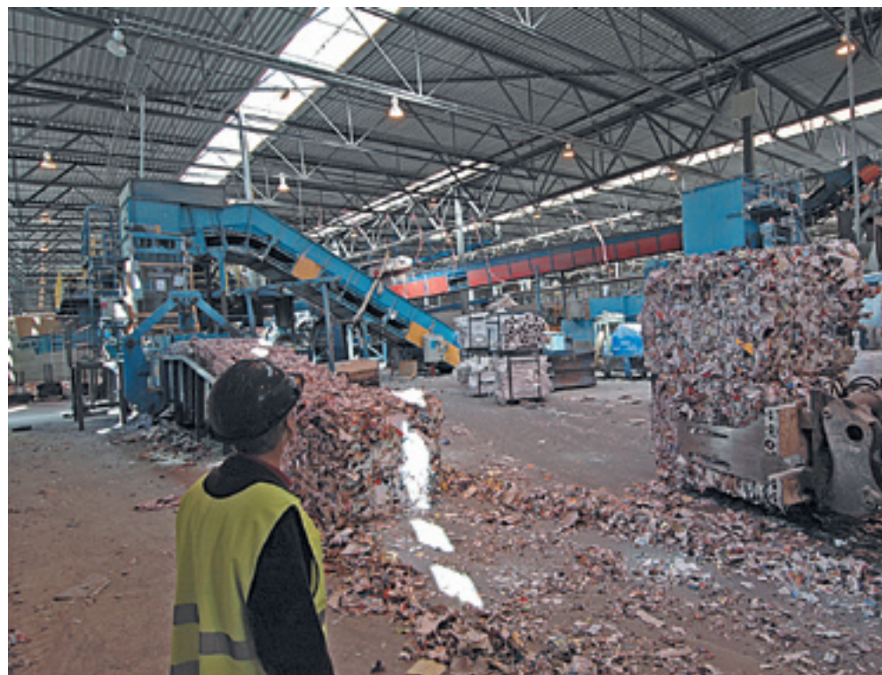
For å bringe mest mulig dagslys inn i gjenvinningsanlegget er det installert store, sammenhengende overlyskonstruksjoner i taket. Det er i alt 14 slike konstruksjoner med bredde 2600 mm og i varierende lengder.
